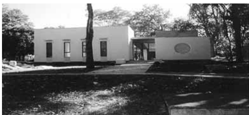
日本文化研究センター (沖縄県・名護市建設)
