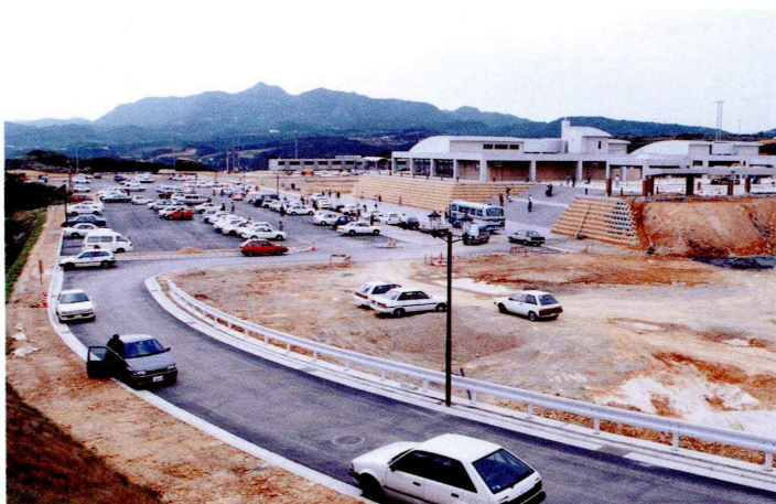
整備中の駐車場と福利厚生施設
