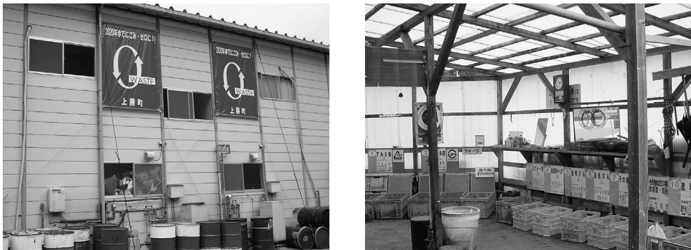
写真2 日比ヶ谷ゴミステーション概観(左)・内部(右)
